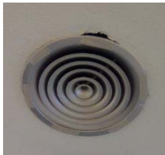
Imagen 11. Difusor cónico de impulsión de aire
